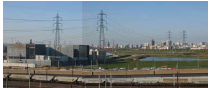
Station d'épuration de Valenton
